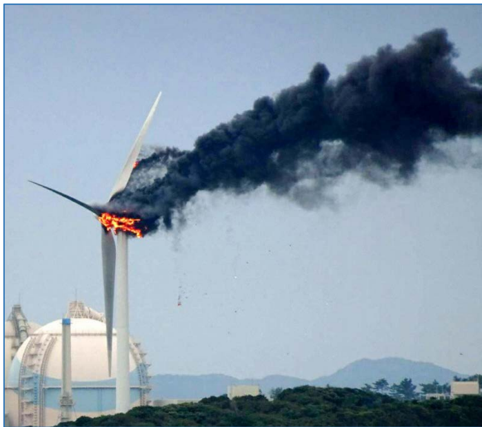
串崎風力発電所火災:佐賀県唐津市、大田潤士さん撮影 朝日新聞社提供-2017年
